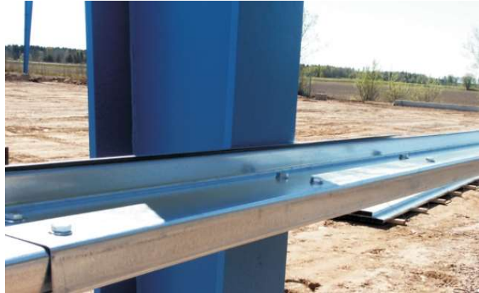
Både för att fästa Z-profilen i konstruktionen och vid överlapp rekommenderas M12-bult.
