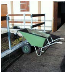
▲ Ett exempel på nedsänkt gödselplatta med ramp för att kunna förvara gödselvattnen (nederbörd som urlakar gödseln). Plattan har säkerhetsstängsel som kan öppnas där man ska tömma gödseln; och en kant som stopper för gödselvagnen. Placeringen nära stallet kortar transportvägen.
